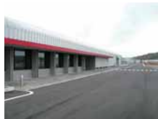
6 外装・外構工事
