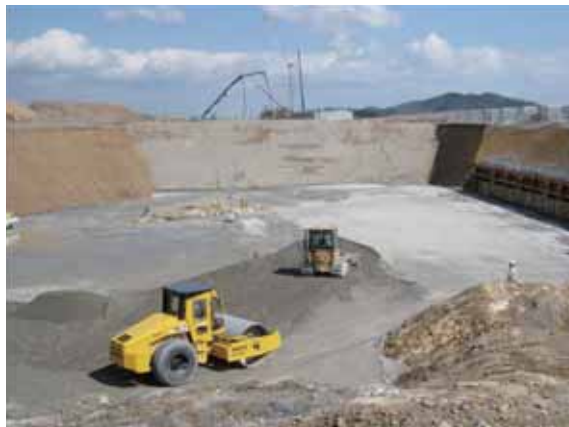
砕石置換の状況
