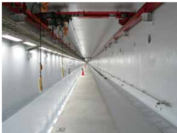
加速器トンネル完成の状況
