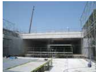
3 コンクリート工事
